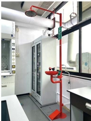
รูปที่ 21 เครื่องล้างตา-ล้างตัวฉุกเฉิน (Emergency Shower and Eye Wash)
