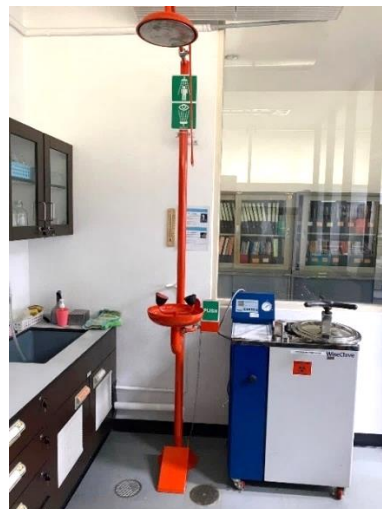
รูปที่ 21 เครื่องล้างตา-ล้างตัวฉุกเฉิน (Emergency Shower and Eye Wash)
