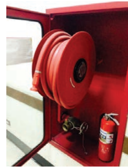
รูปที่ 9 ตู้ดับเพลิงที่มีสายส่งน้ำแบบขมวด
