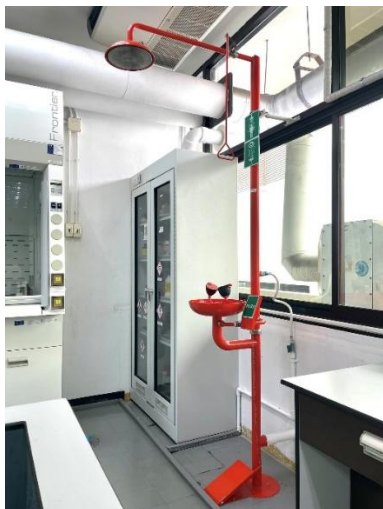
รูปที่ 23 เครื่องล้างตา-ล้างตัวฉุกเฉิน (Emergency Shower and Eye Wash)
