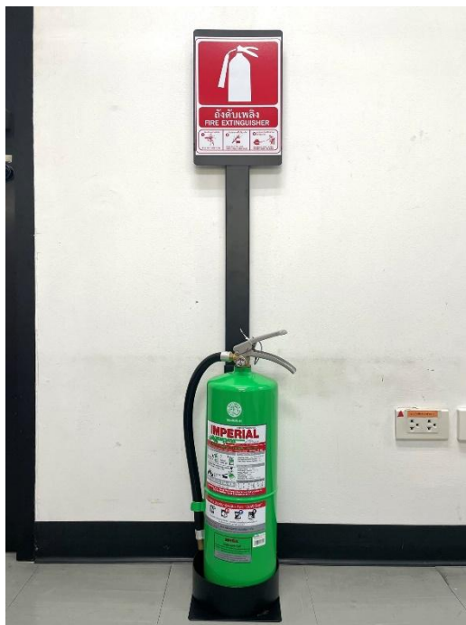
รูปที่ 25 ถังดับเพลิงของศูนย์ทดสอบชีววัสดุ เป็นประเภท Low Water Pressure สามารถดับประเภทของไฟชนิด A B C และ K ได้
