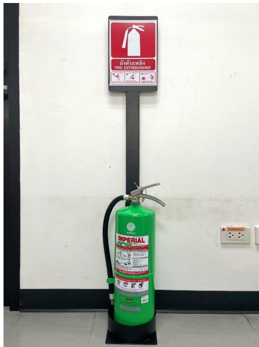
รูปที่ 9 ถังดับเพลิงของศูนย์ทดสอบชีววัสดุ เป็นประเภท Low Water Pressure
